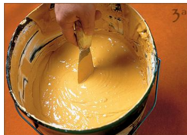
Fase 5 - Terza Mano, un trucco importante per avere una facile lucidatura consiste nel miscelare Spatula Stuhhi per renderlo piú liquido.
