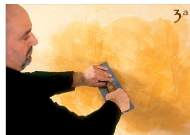
Fase 8 - ... 30 secondi dopo e con la spatola ben pulita lucidiamo in questo modo. Passando al mq successivo sovrapponiamo al precedente eliminando cosí qualsiasi segno di giunzione.
