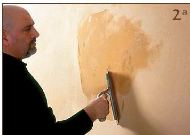
Fase 4 – Seconda Mano, la superficie é perfettamente asciutta ed assorbente per una rasatura completamente liscia, requisito ideale per un'ottima Terza Mano.
