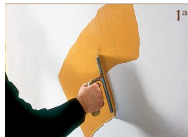
Paso 3 - Primera Mano - Durante la aplicación, el producto se suelta, facilitando el trabajo.
