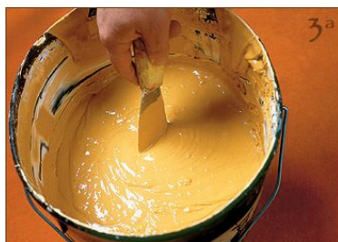
Paso 5 - Tercera Mano - Un truco importante para obtener un fácil pulido consiste en mezclar Spatula Stuhhi hasta hacerlo más líquido.
