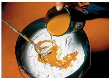
Paso 2 - Preparar el tinte con los colores que indicamos en el muestrario y mezclar con el batidor de alambres; dejar reposar 24 horas.
