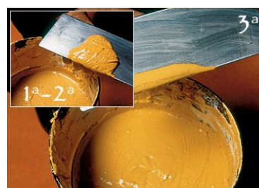
Paso 6 - En la siguiente imagen vemos las 2 consistencias que pueden obtenerse. Sobre todo en la tercera mano, recomendamos usar nuestras espátulas especiales.
