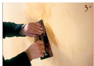
Paso 7 - Llegados aquí, el producto penetrará hasta en las más pequeñas rendijas, y bastará una ligera presión para que la superficie quede completamente lisa. Aplicamos... y quitamos Spatula Stuhhi en una superficie aproximada de 1 m 2 y ...
