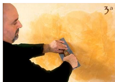
Paso 8 - ... 30 segundos después, pulimos como se indica con la espátula bien limpia. Al pasar al siguiente m 2 , trabajamos en superposición al anterior para así eliminar cualquier signo de junta.
