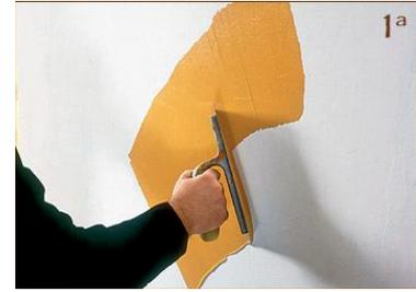
Schritt 3 - Erste Schicht - Während der Auftragung entspannt sich das Produkt und macht somit diese Arbeit sehr leicht.
