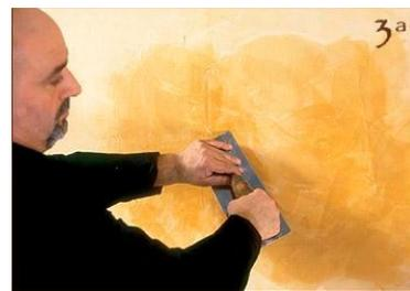
Schritt 8 - ... 30 Sekunden später und mit einem ganz sauberen Spatel polieren wir auf diese Art und Weise. Beim Übergang auf den nächsten m<sup>2</sup> überdecken wir den vorhergehenden wodurch jede Art Markierung einer Schnittstelle beseitigt wird.
