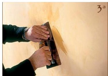
Schritt 7 - An dieser Stelle wird nun das Produkt in jeden kleinen Spalt eindringen und mit einem leichten Druck wird die Oberfläche ganz glatt werden. Auftragen... und entfernen Spatula Stuhhi für etwa 1 m<sup>2</sup> und ...
