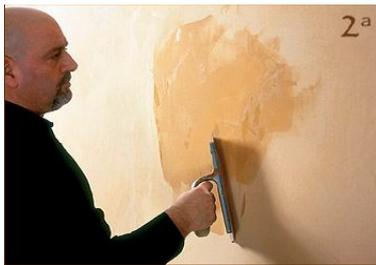
Schritt 4 - Zweite Schicht - Die Oberfläche ist vollkommen trocken und aufnahmefähig für eine vollkommen glatte Rasur, die ideale Voraussetzung für eine optimale DRITTE SCHICHT.
