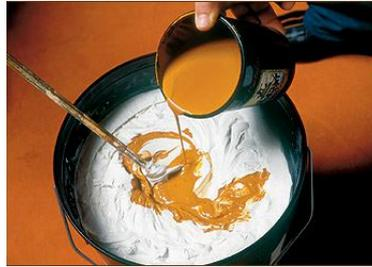
Schritt 2 - Den Anstrich vorbereiten mit Hilfe unserer in der Musterkollektion angeführten Farben und dann mit dem Schaumschläger mischen. 24 Stunden lang ruhen lassen.
