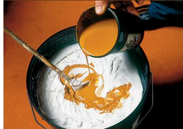
Étape 2 - Préparer la teinte avec nos couleurs reportées sur l'échantillonnage et malaxer avec le mélangeur; faire reposer pendant 24 heures.
