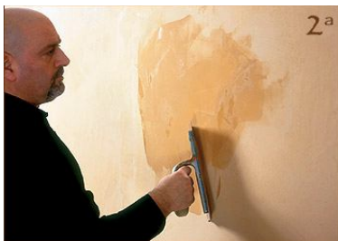
Étape 4 - Deuxième Couche - La surface est parfaitement séchée et absorbante pour un ragréage lisse, une condition idéale pour une excellente TROISIÈME COUCHE.
