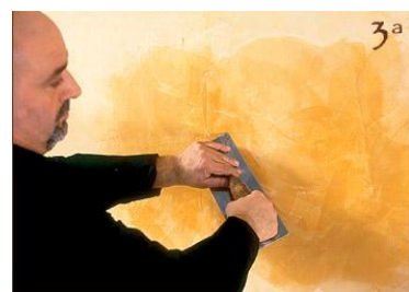
Étape 8 - ... 30 secondes après, avec la lame à enduire propre, polir de la façon indiquée. Quand on passe au m 2 suivant, se superposer à la zone précédente pour éliminer tout signe de jonction.
