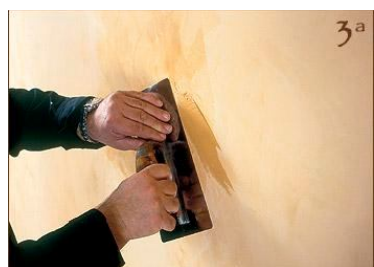
Étape 7 - À ce point, le produit pénètre dans chaque petite fissure et, avec une légère pression, la surface devient parfaitement lisse. Appliquer... et enlever Spatula Stuhhi sur environ 1 m 2 et ...
